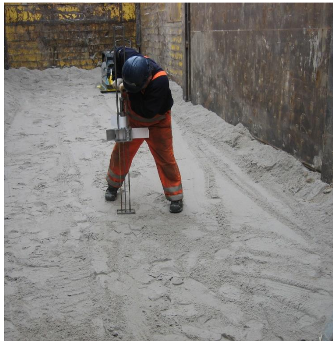
Foto: voorbeeld van het meten van de verdichting van het zandpakket.
