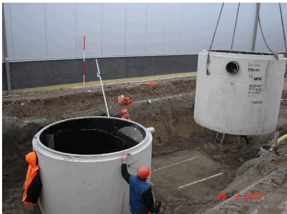
Foto: voorbeeld van het plaatsen van een afzonderlijke slibvangput en olie-waterafscheider.
